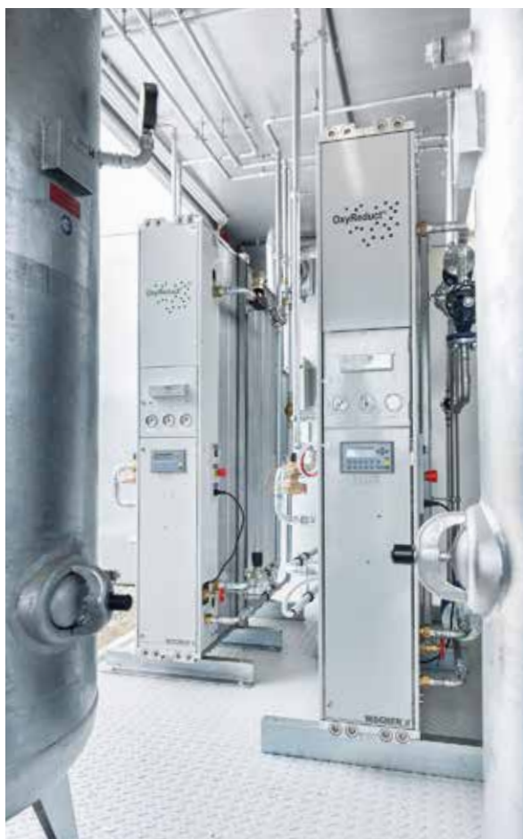
OxyReduct® P-Line Sauerstoffreduktionsanlage
