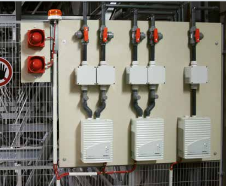
TITANUS® Ansaugrauchmelder zur frühestmöglichen Rauchdetektion
