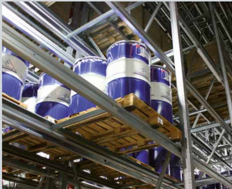
Produkte verschiedener Gefahrstoffklassen unter einem Dach, sicher vor Brandrisiken geschützt
