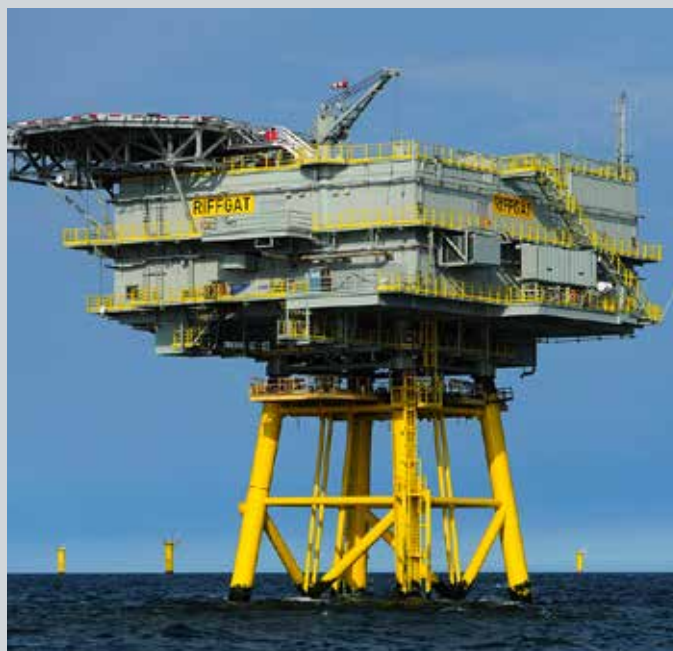
Mit Brandschutztechnik von WAGNER ausgestattet: Die Umspannstation des Windparks Riffgat
