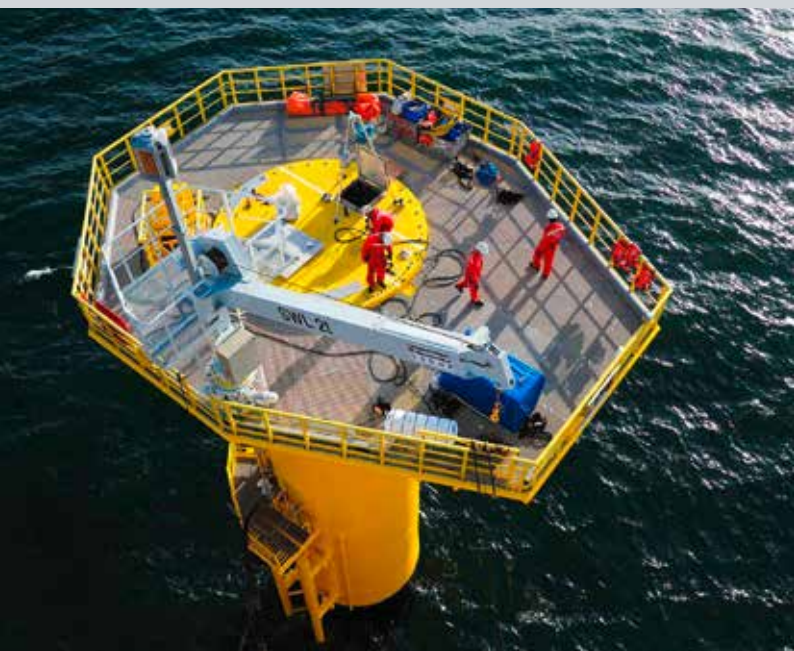
Die Plattform wird für die Montage eines Windrades vorbereitet
